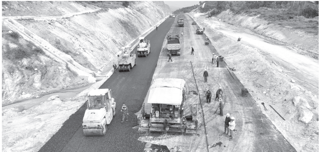
Công tác đầu tư xây dựng cơ bản được tập trung chỉ đạo quyết liệt. Trong ảnh: Các đơn vị thi công đang đẩy nhanh tiến độ xây dựng Dự án cao tốc Bắc - Nam, đoạn qua địa bàn tỉnh Phú Yên. Ảnh: NGÔ XUÂN
