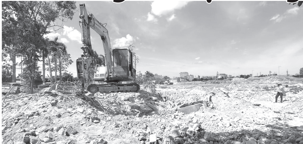
Công nhân đang thực hiện phá dỡ hạng mục vi phạm trả lại mặt bằng cho Dự án hồ điều hòa Hồ Sơn cùng hạ tầng xung quanh. Ảnh: MINH DUYỄN
