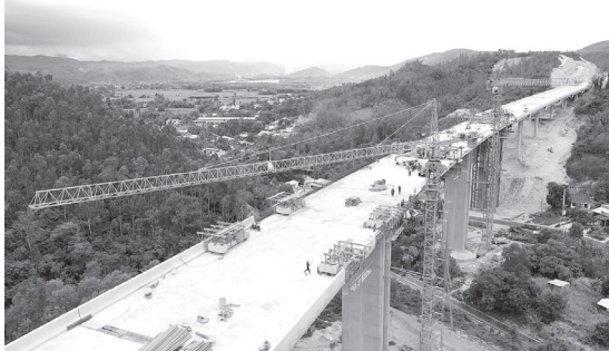
Cầu Km65+012 được thi công trong điều kiện địa hình phức tạp, hiểm trở với nhiều núi cao và băng qua đường sắt Bắc - Nam
