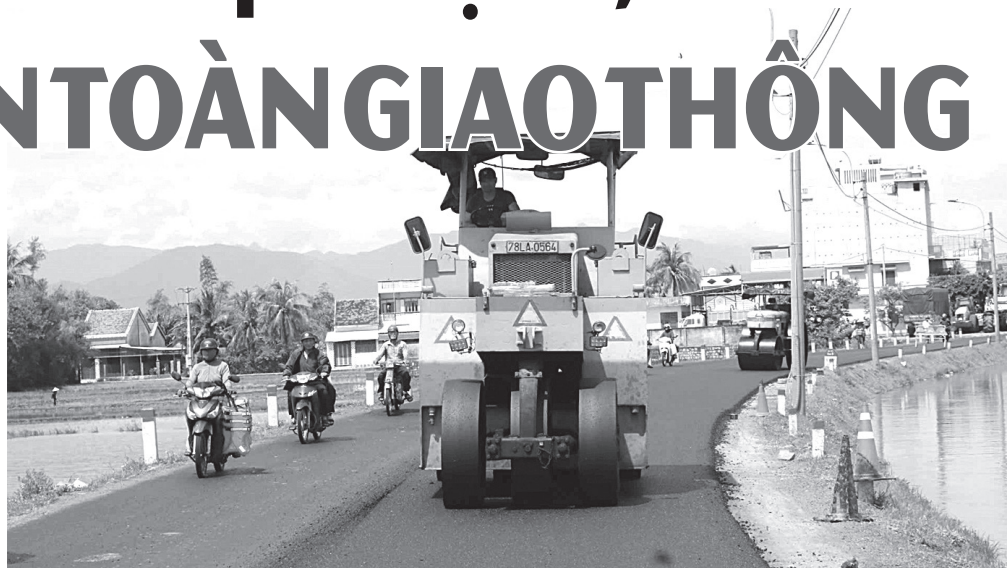
Đơn vị thi công đang tập trung đẩy nhanh tiến độ thi công trên tuyến quốc lộ 25, đoạn qua địa bàn huyện Phú Hòa.
