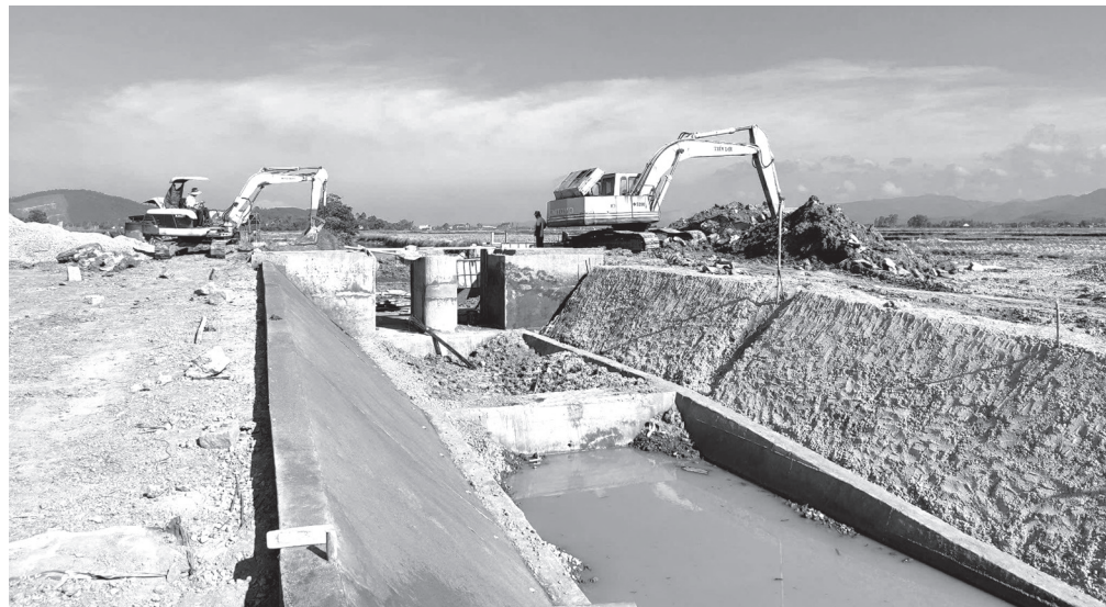
Trạm thủy nông kênh Bắc tổ chức gia cố, sửa chữa vị trí mái trong bờ tả kênh, đáy kênh và làm mới cống tưới ở khu vực huyện Phú Hòa. Ảnh: NGỌC HÂN
