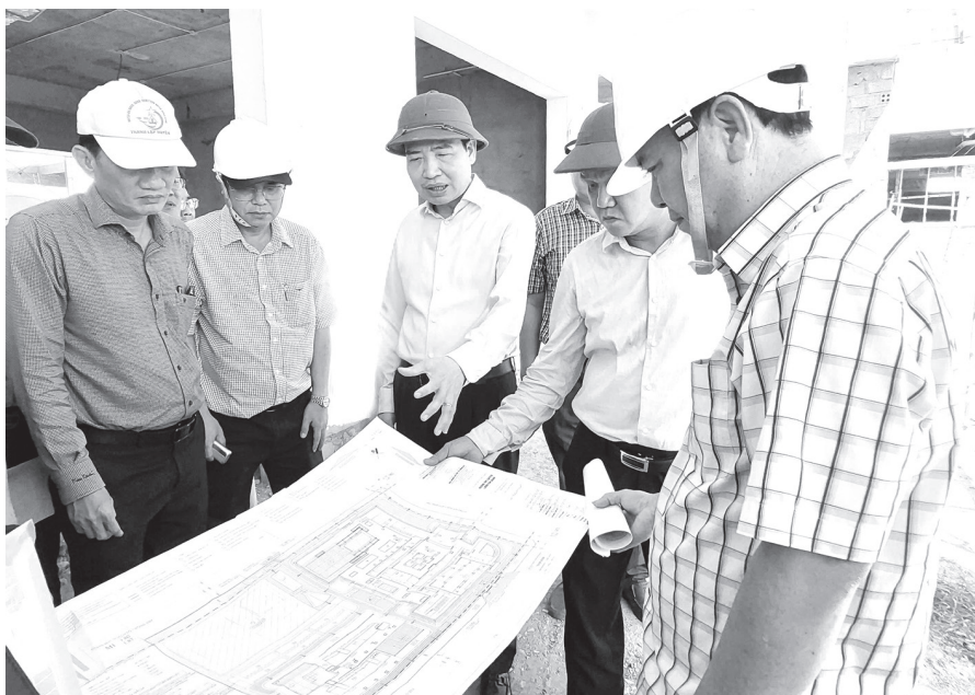
Chủ tịch UBND tỉnh Tạ Anh Tuấn (thứ ba từ trái qua) kiểm tra thực địa công tác thi công Bệnh viện Sản - Nhi Phú Yên
