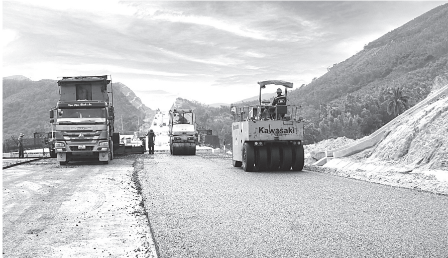
Các nhà thầu, đơn vị thi công làm việc xuyên các kỳ nghỉ lễ để thực hiện mục tiêu thông tuyến cao tốc Bắc - Nam trong năm 2025. Ảnh: NGÔ XUÂN
