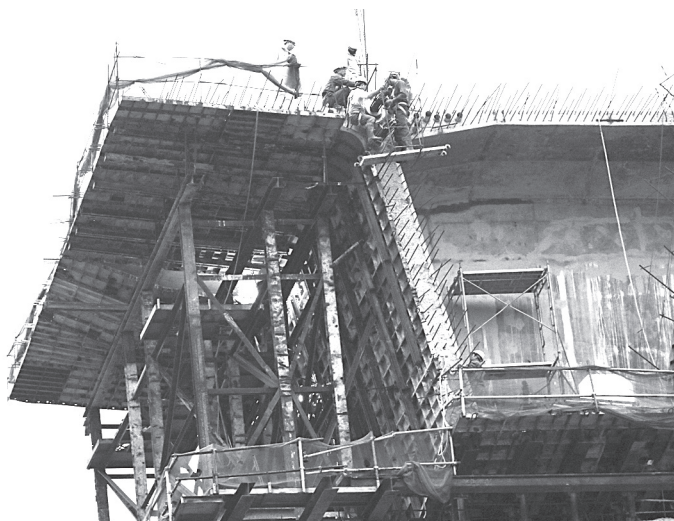
Công nhân làm việc xuyên đêm trên công trường thi công cao tốc Bắc - Nam. Ảnh: NGÔ XUÂN
