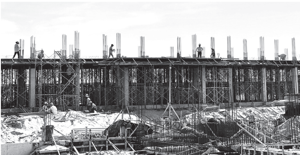
Công nhân tham gia thi công tại công trình Trường THPT chuyên Lương Văn Chánh. Ảnh: NHƯ THANH
