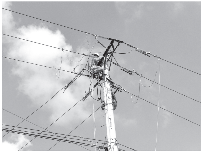
Công nhân Công ty Điện lực Phú Yên sửa chữa trên lưới điện. Ảnh: THỦY TIỀN
