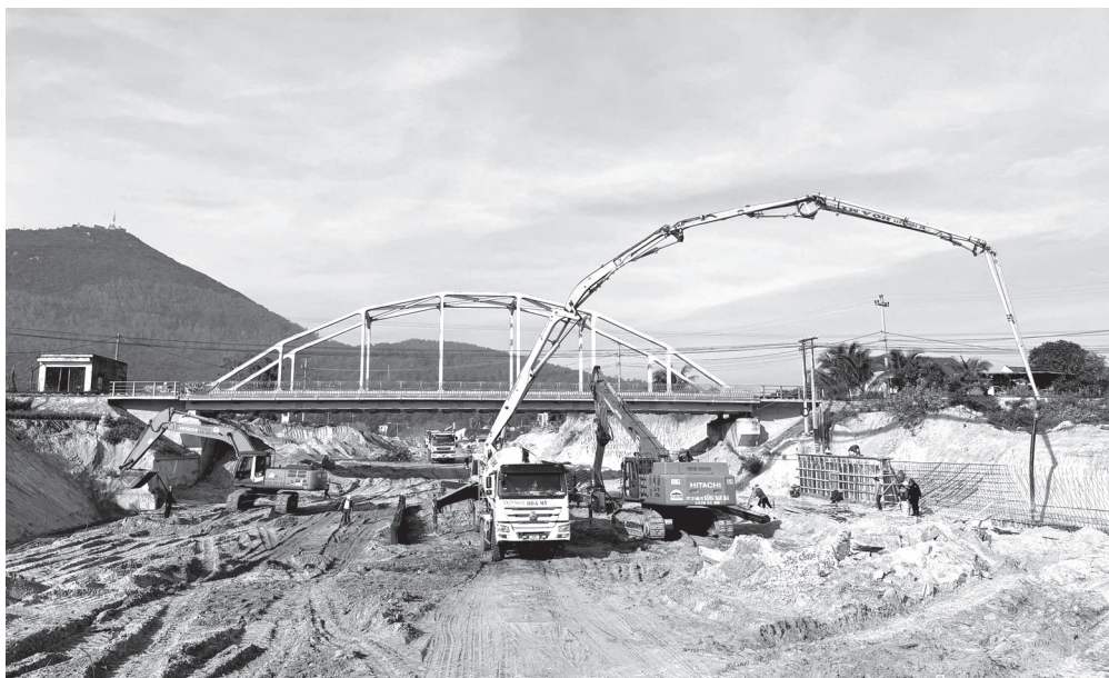
Các đơn vị thi công tập trung máy móc thiết bị, nhân lực quyết tâm hoàn thành Dự án tuyến đường số 14 trong tháng 9/2025. Ảnh: NGÔ XUÂN
