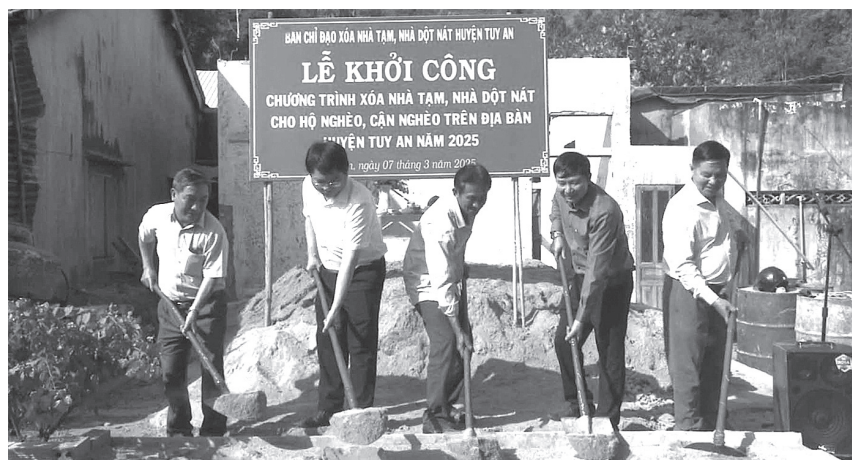
Lễ khởi công đồng loạt thực hiện Đề án xóa nhà ở tạm bợ, dột nát cho hộ nghèo, hộ cận nghèo trên địa bàn huyện Tuy An
